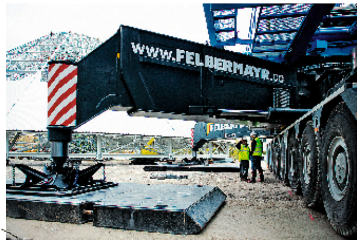
Standfest: Damit der Kran sicher steht, muss der Grund zuvor verdichtet werden. Denn ein kippender Kran ist nicht aufzuhalten
